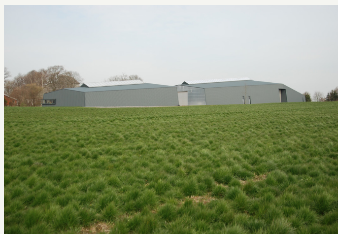
Der er foretaget en ganske lille terrænregulering, dog er den høje del af bygningen gravet fra 0,5 til 1 m ned i terrænet. Foto: VfL
