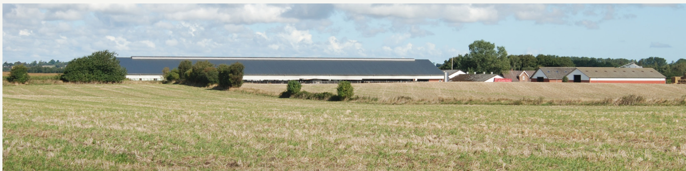
Et stort staldanlæg delvist nedgravet i terrænet, med den virkning at bygningen ligger fint som en integreret del af landskabet. Foto: VfL
